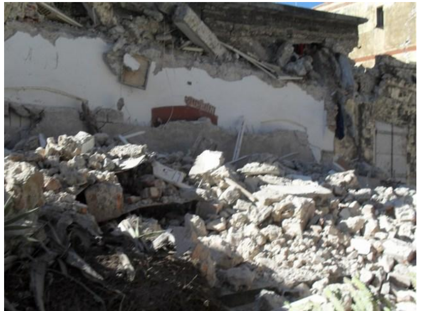
Figure 3: Image du tremblement de terre Centre ville de Jacmel
