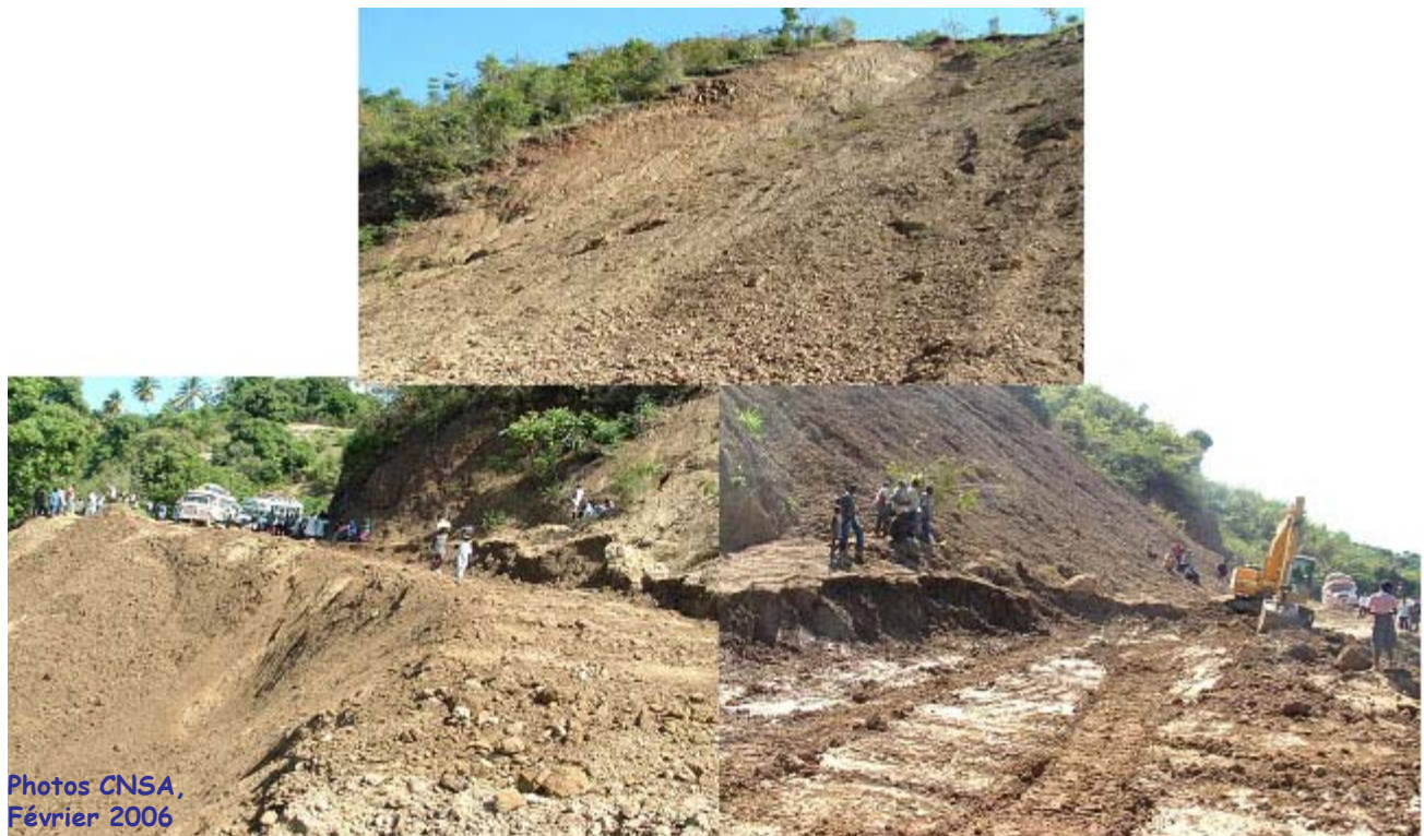
FIGURE 1. GLISSEMENT DE TERRAIN A BARBIER, AXE BEAUMONT-ROSEAUX
